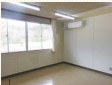
図書室 (空調・照明新設)
