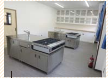
実習室 (照明調理台収納棚空調新設、床壁貼替え)
