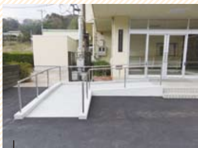
スロープ (改良)
