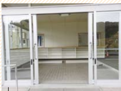
正面玄関 (開き戸から引き戸へ改修)
