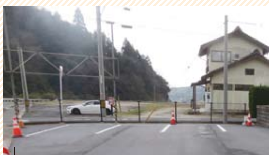
フェンス (生垣を撤去し新設)
