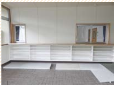
下駄箱・カウンター・窓口 (改修)
