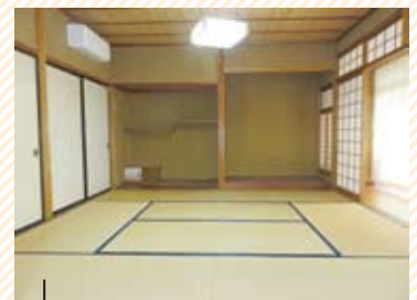
和室南側 (空調・照明・網戸新設)
