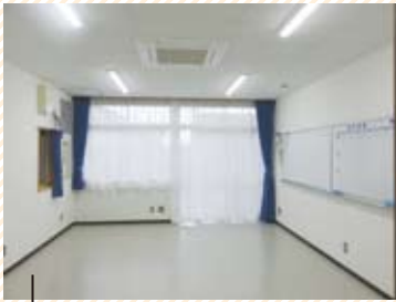
事務室 (空調・照明改修、床・壁貼替え)
