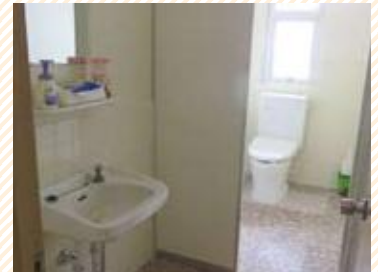
2階トイレ (和式から洋式へ改修)
