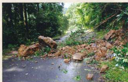
落石により通行止めとなった伊野本線
