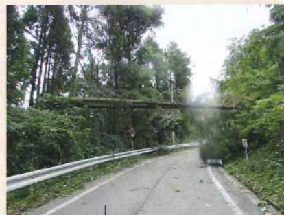
倒木により停電が発生した斐川一畑大社線地合工区
