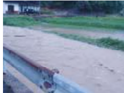
伊野川増水により水田が冠水
