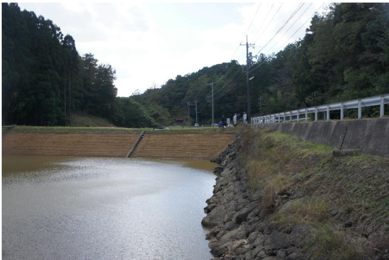
土手の補修を終えた高山町内の大床池
